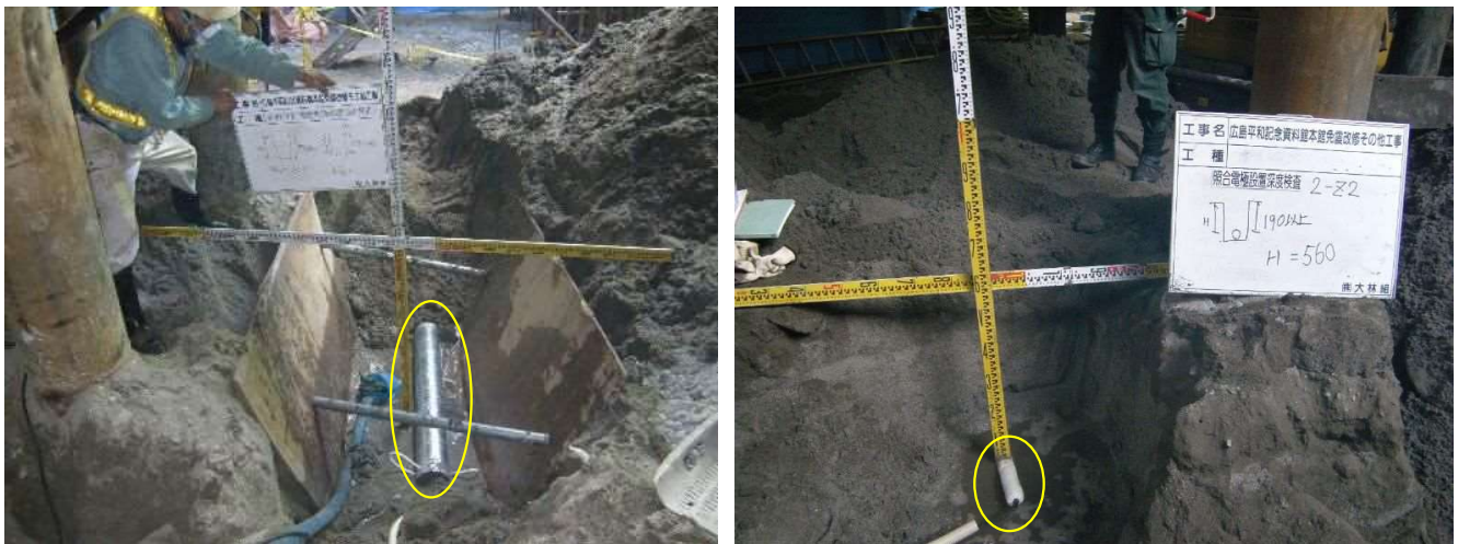
写真-1 施工状況
